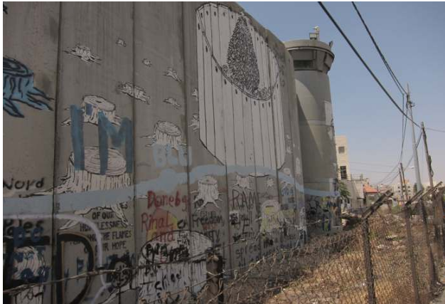
تصویر ۵. دیوار جداکننده (The separation Wall) میان اسرائیل و کرانه باختری؛ عکسی که در نزدیکی ایست‌بازرسی شماره ۳۰۰ گرفته شده (بیت‌لحم/محدوده بیت‌المقدس) در سمت فلسطینی نشین؛ تمهیدی قطعی، محرز و قدرتمند از جدایی‌گزینی فضایی که به‌شکلی صریح و از طریق ساخت فرم‌های عینی و انضمامی، مادیت یافته است. (Benjamin Leclair-Paquet, 2010)
